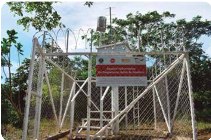
Estación hidrométrica instalada en Río Desparramo, Bahía de Jiquilisco.
