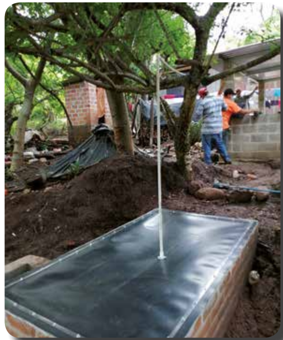
Construcción de biodigestores.
