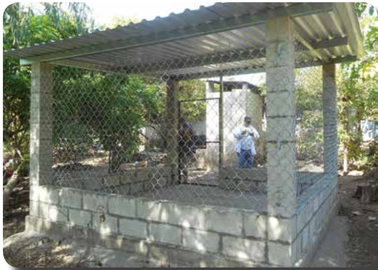
Construcción de granjas avícolas.
