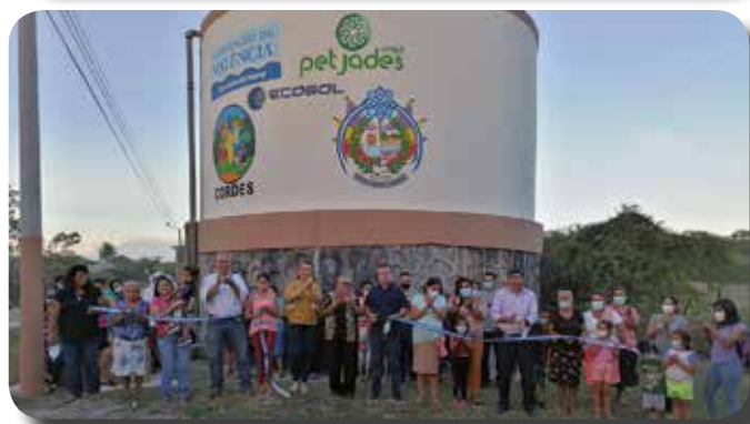
Zanjos para cañerías y corte de cinta en inauguración
