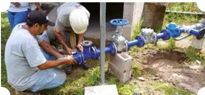
Foto 7: Instalación de válvulas y micromedido.
