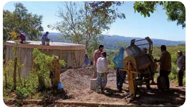
21. Finalización construcción tanque de distribución de agua para Barrio Aguacayo, San José Guayabal.
