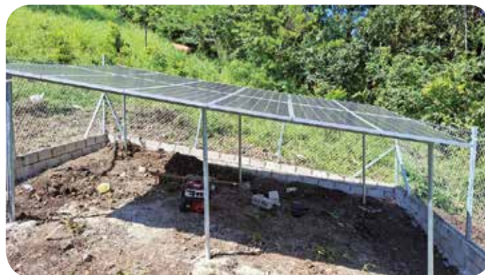
22. Sistema fotovoltaico para bombeo de agua potable en comunidad El Coco, Jutiapa.
